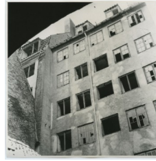
Adelgade baghus 1954 nedrivning
