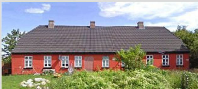
Rytterskolen i Nr. Vedby bygget ca. 1722
