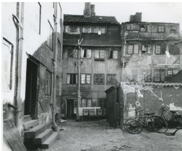
Dronningensgade 37, gårdfacade og sidehus, 1966
